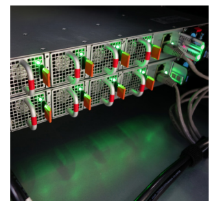
不间断电源设备
