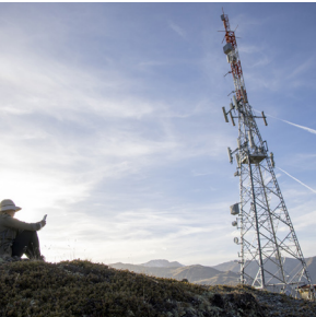
塔式通信系统
