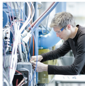
配电和充电系统
