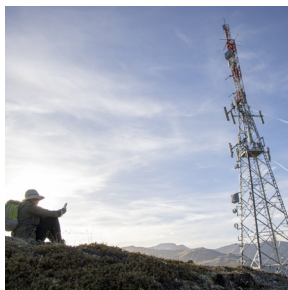
タワーベースの通信システム
