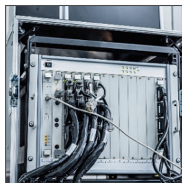
試験装置のコントロールパネル
